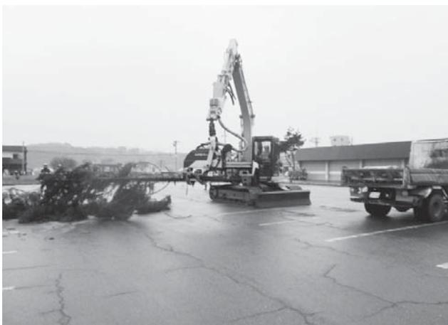
救急救助支援隊はチェーンソーにより倒木を切断、協力事業所についてはバックホーにより倒木の枝及び幹を切断後、連携してトラックに積載し道路開通訓練を実施しました。
